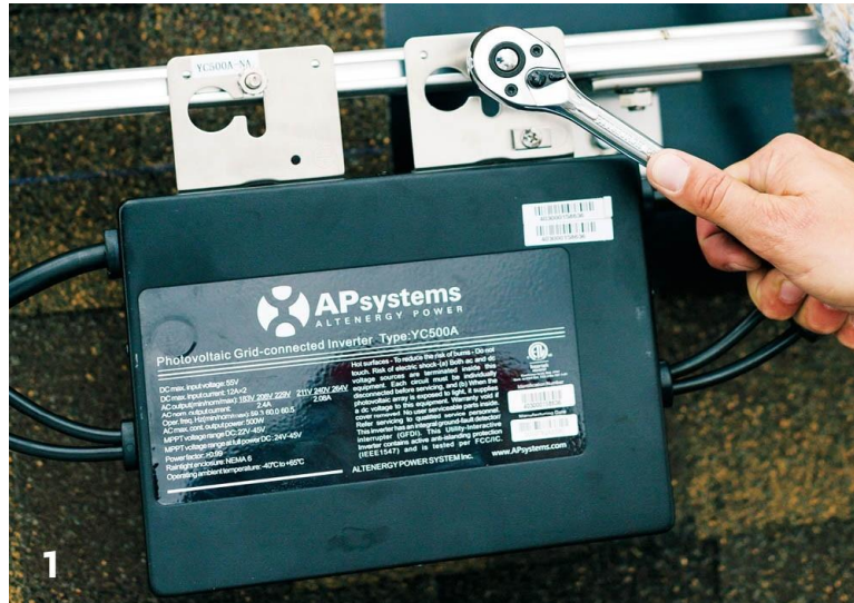
Gambar 6.19 Pemasangan mikro inverter ke rel
