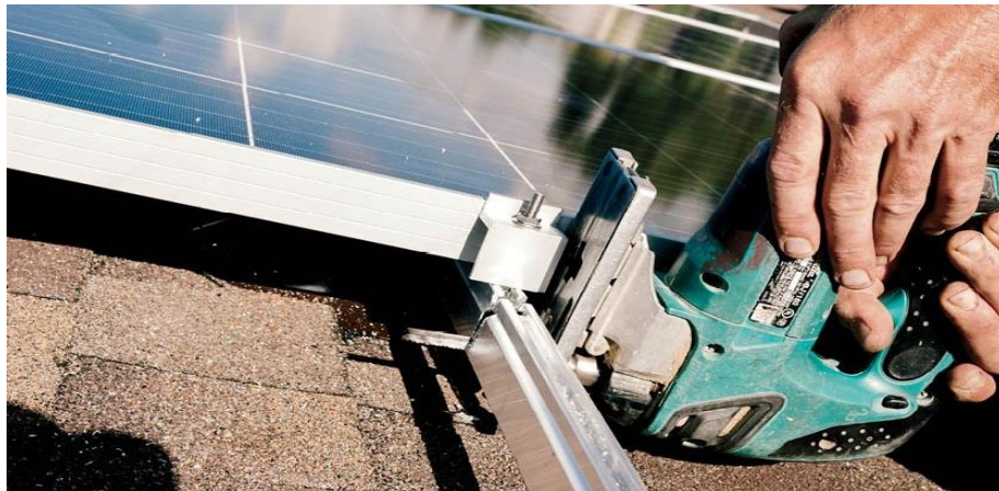
Gambar 6.32 Pemasangan modul yang tersisa
