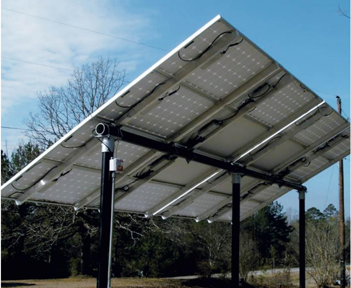
Gambar 3.16 Pemasangan multi-kutub
