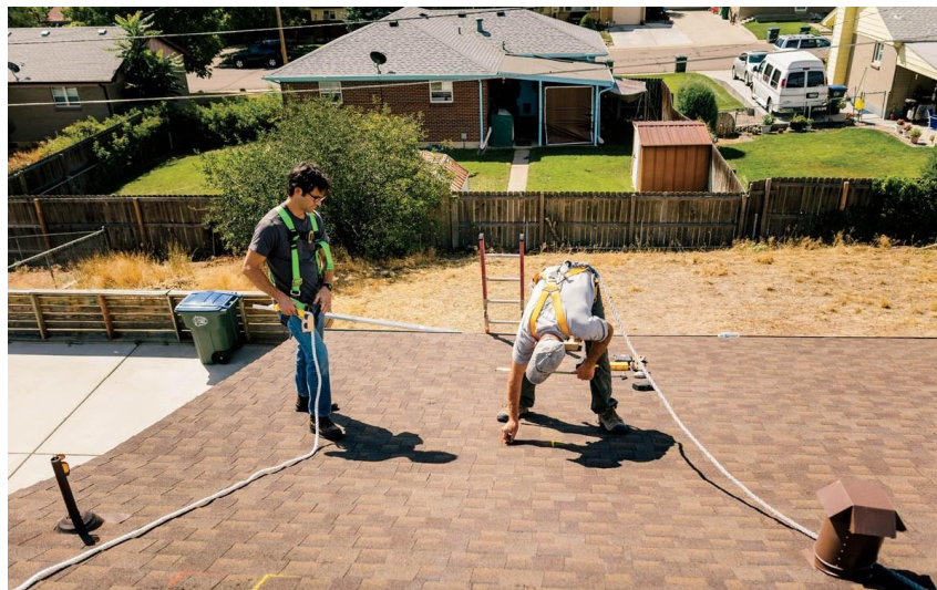
Gambar 6.1 Kegiatan proses pemasangan di atap
