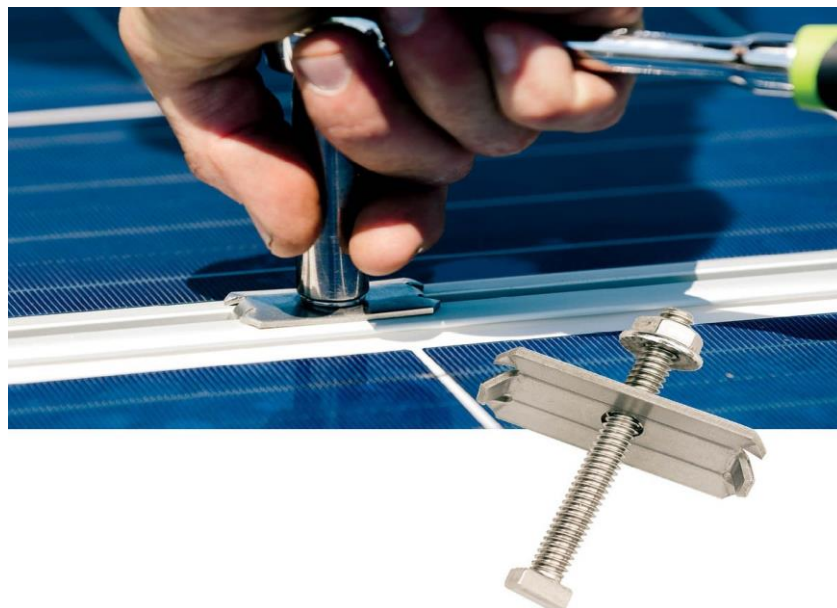
Gambar 3.11 Penjepit tengah modul dengan gigi untuk mengikat modul ke rel (tidak diperlukan WEEB terpisah). Klem tengah mengikat dua bingkai modul sekaligus. Gigi menghadap ke bawah untuk menggigit bingkai logam.
