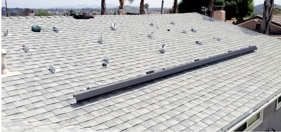
Gambar 3.8 Pemasangan di atap dan skirting dipasang untuk sistem pemasangan tanpa rel. Skirting bersifat opsional dan memberikan tampilan akhir ke bagian larik yang paling terlihat.
