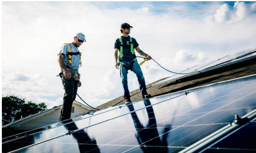
Gambar 5.6 Pemasangan jangkar didorong ke kasau atap
