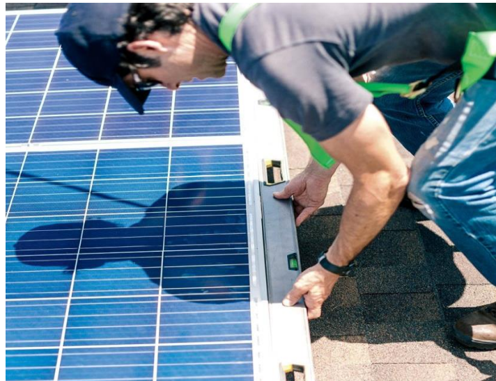
Gambar 6.30 Melanjutkan pemasangan modul pada bawah baris
