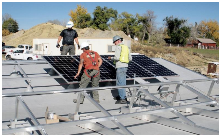
Gambar 1.17 Pemasangan Panel Surya dengan Profesional
