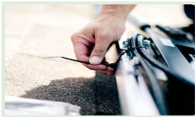
Gambar 6.34 Ikatan kawat plastik dapat membungkus seluruh rel dan berguna untuk mengikat gulungan kawat.
