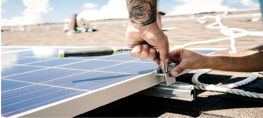
Gambar 6.31 Mengencangkan modul luar dengan sepasang klem ujung
