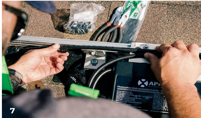
Gambar 6.25 Mengencangkan kabel rel dengan klip kabel
