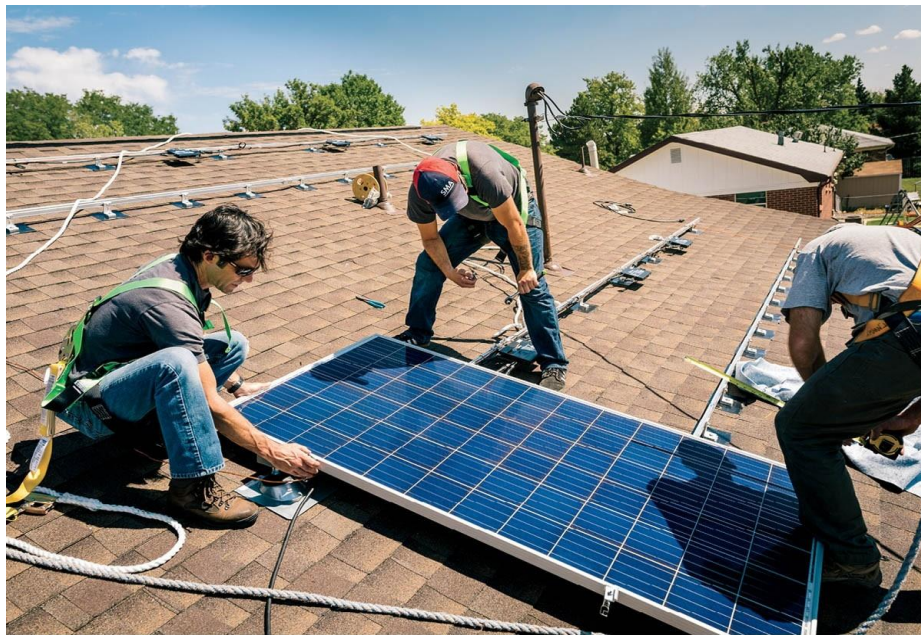
Gambar 6.28 Proses penginstalan modul pertama ke rel
