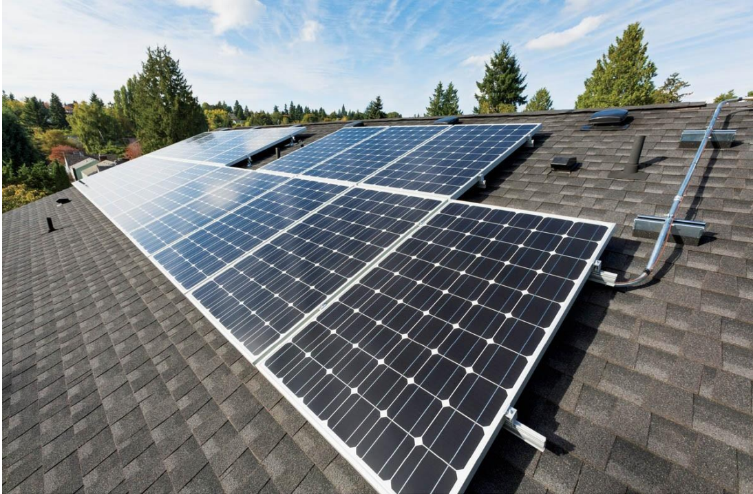
Gambar 8.2 Pemasangan saluran dengan jangkar dan lampu kilat yang ditinggikan.
