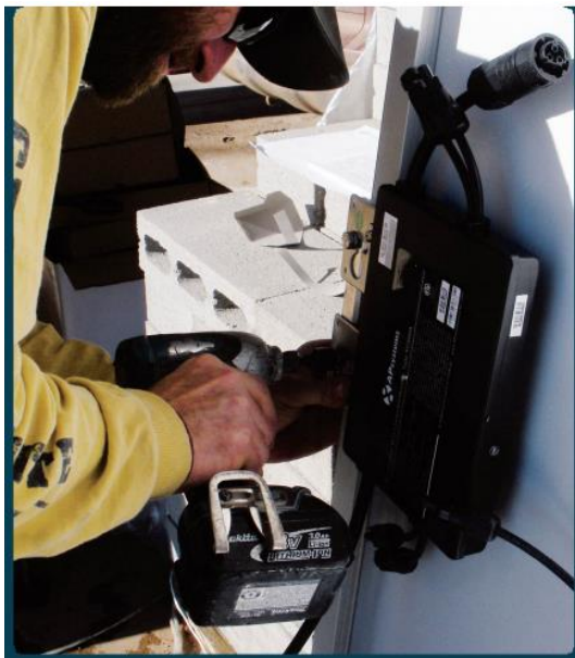
Gambar 6.18 Pemasangan bingkai mikroinverter
