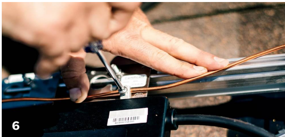
Gambar 6.24 Hubungkan kabel arde ke tiap kotak mikroinverter
