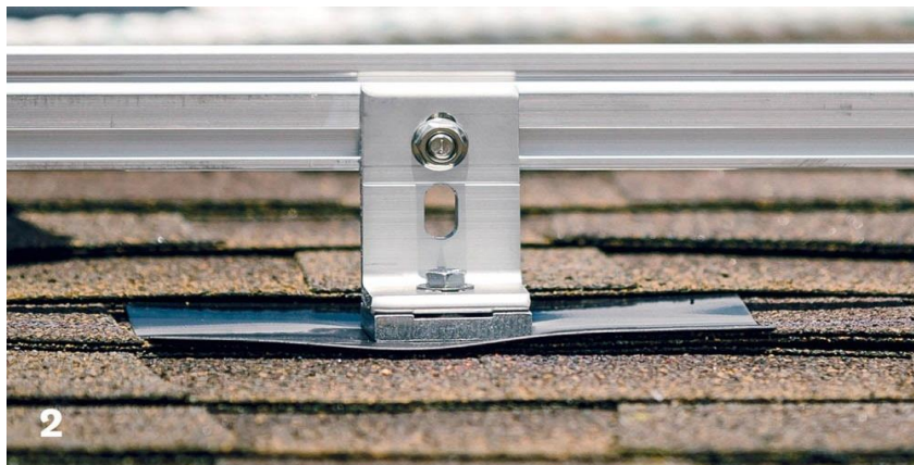
Gambar 6.14 Pengaturan ketinggian rel pada ujungnya
