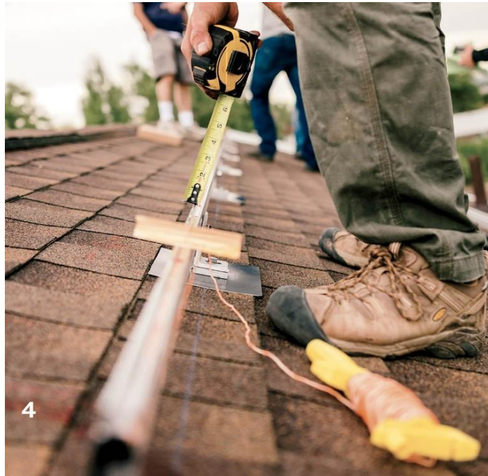
Gambar 6.16 Pelurusan rel dari satu ujung ke ujung lainnya
