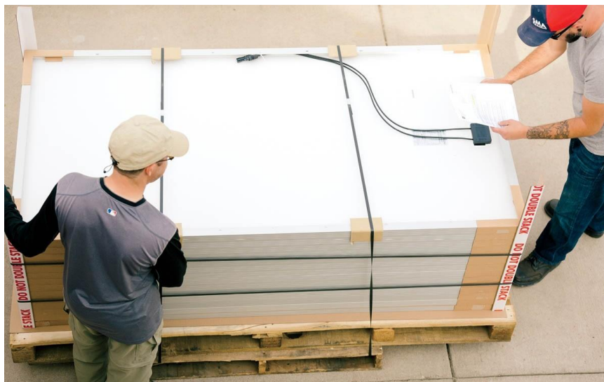
Gambar 5.1 pengecekan modul
