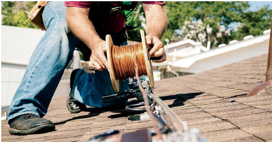
Gambar 8.1 Pembengkokkan saluran dan penarikan kabel
