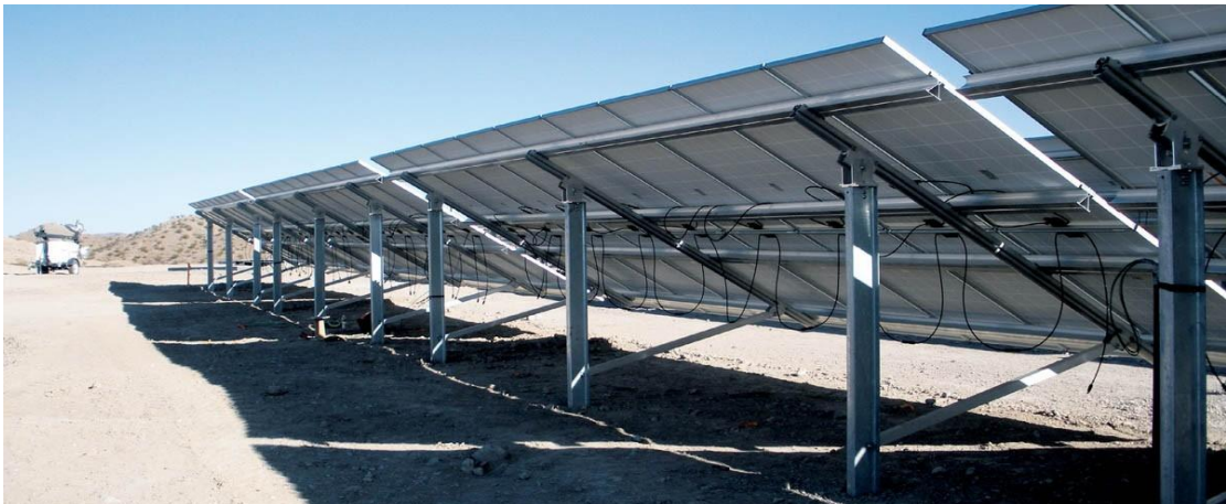
Gambar 3.14 Desain ground-mount standar, tiang tunggal, kantilever
