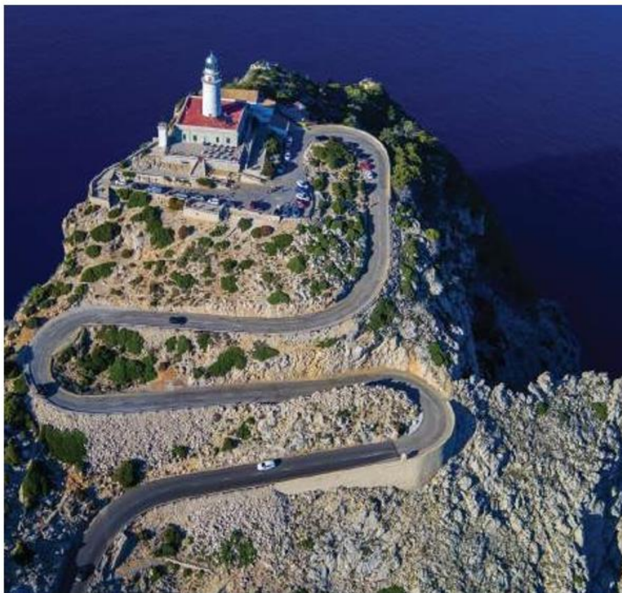
Gambar 5.1 Gambar sebuah jalan menuju sebuah gedung, lokasinya memiliki tekstur bebatuan.
