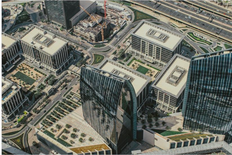
Gambar 5.60 Sebuah gedung yang sangat besar yang begitu mencolok berada ditengah hamparan bangunan lainnya
