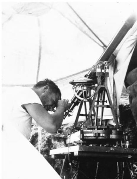
Gambar 3.12 : Pengamatan astronomi digunakan dalam survei geodetik awal untuk mengukur lokasi datum (milik NOAA).
